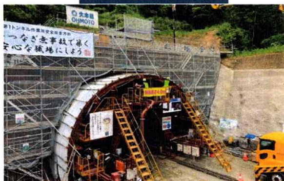
コンクリート打設状況
